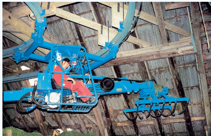
↑ Kurvenfahrwerk mit selbstregulierendem Parallelausgleich und Tandemfahrwerk
