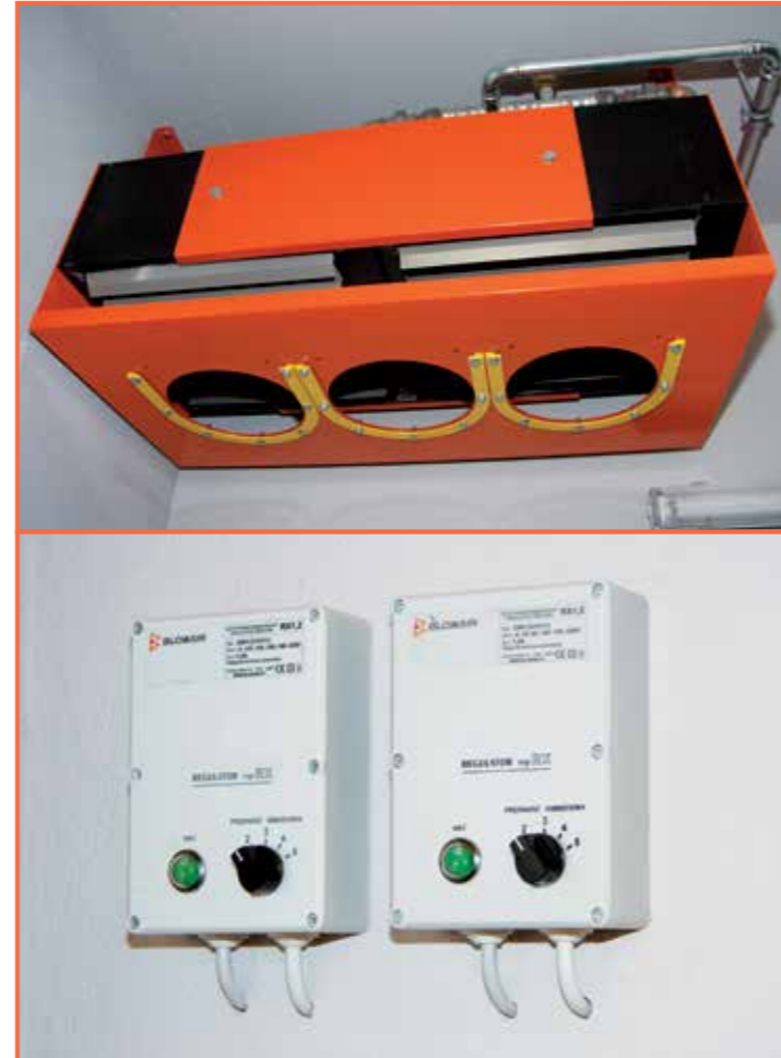
Kompakter Wärmetauscher zur Anwärmung der Ansaugluft
